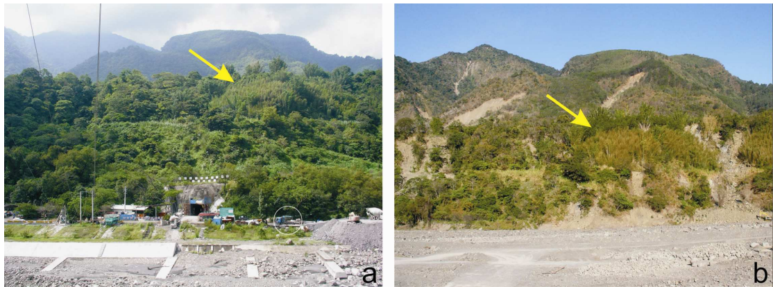
圖 2 「曾文溪越域引水計畫」施工用隧道口(銜接引水隧道)，莫拉克颱風前、後的對比。(a)颱風前(攝於 2007 年 11 月)。圈出者乃作為比例尺的卡車。(b)颱風後(攝於 2009 年 12 月)。隧道已悉被土石掩埋。荖濃溪由右向左流。兩圖箭頭指出的竹林乃同一竹林。
